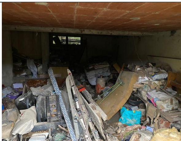
Cave en rez-de-chaussée
