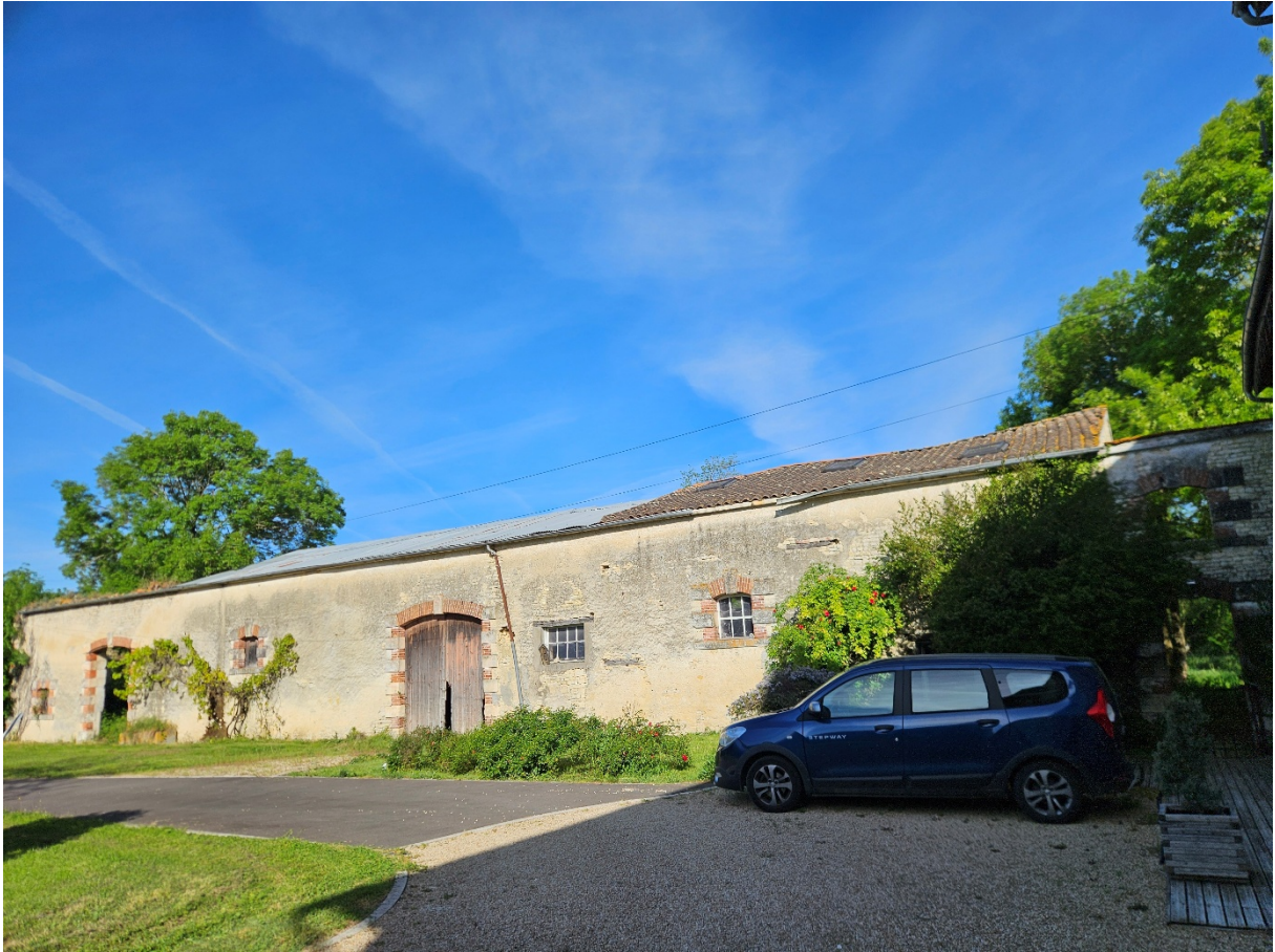
Grange à rénover
