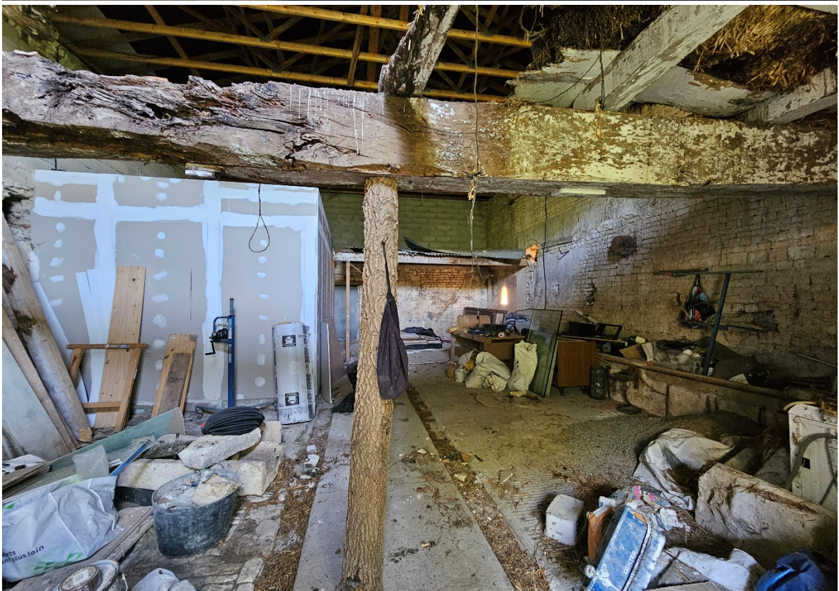
Partie de grange à rénover côté gîtes
