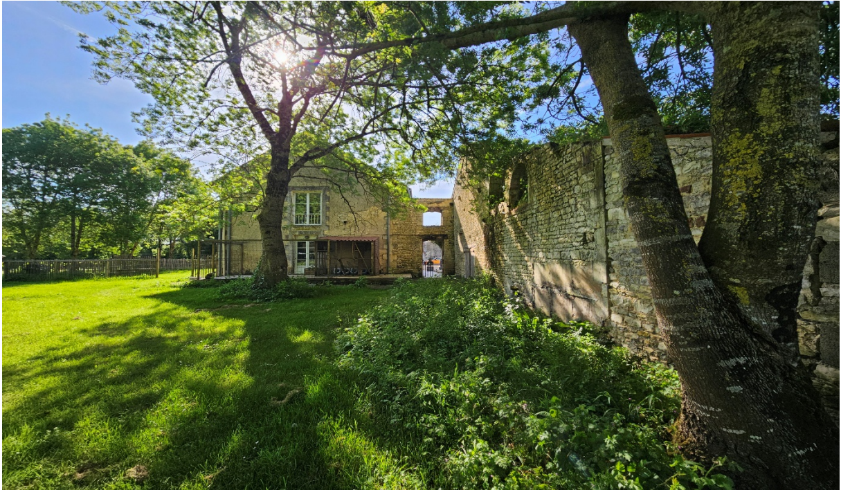
Pignon partie habitation
