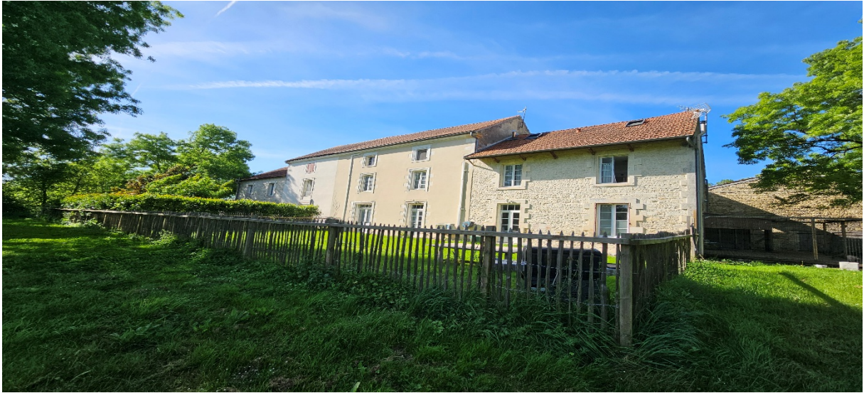
Vue arrière partie habitation
