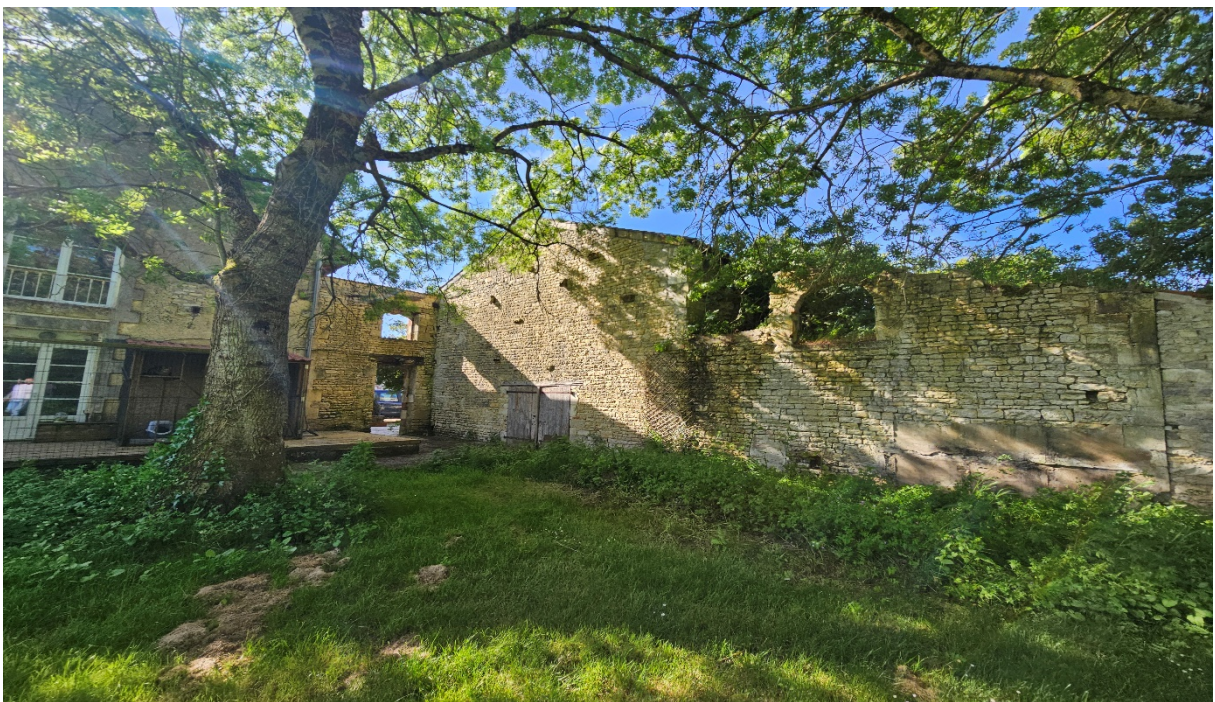
Pignon partie habitation
