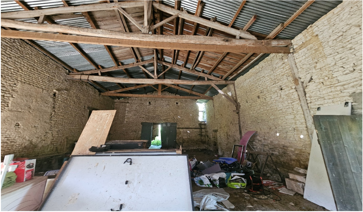
Grange à rénover
