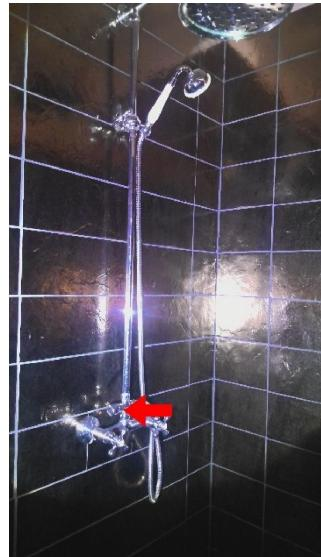
**B.5.3 a)** : Locaux contenant une baignoire ou une douche : la continuité électrique de la liaison équipotentielle supplémentaire, reliant les éléments conducteurs et les masses des matériels électriques, n'est pas satisfaisante (résistance supérieurs à 2 ohms).
