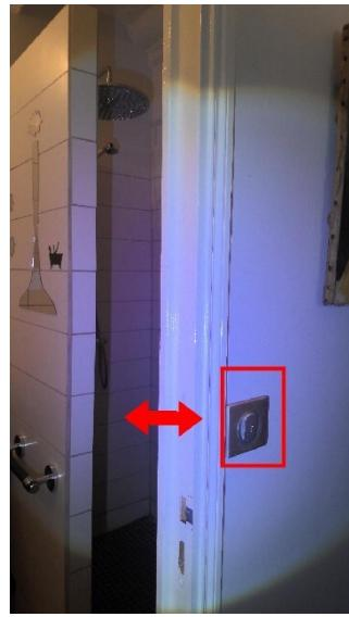
**B.6.3.1 a)** : Local contenant une baignoire ou une douche : l'installation électrique ne répond pas aux prescriptions particulières appliquées à ce local (adéquation entre l'emplacement où est installé le matériel électrique et les caractéristiques de ce dernier - respect des règles de protection contre les chocs électriques liées aux zones).
