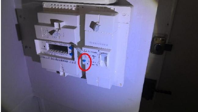
**B.2.3.1 i)** : La manœuvre du bouton test du (des) dispositif(s) de protection différentielle n'entraîne pas (son) leur déclenchement.
